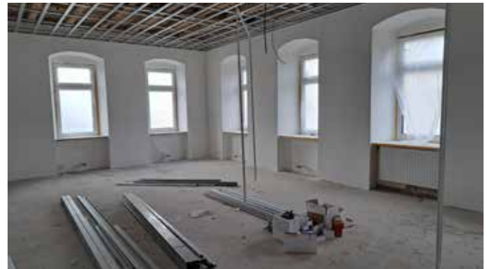
Volksschulsanierung liegt im Zeitplan.
