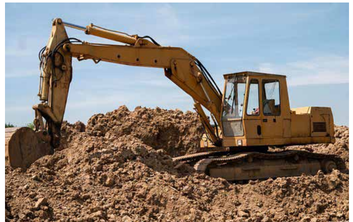
Erdablagerung in Moos möglich
